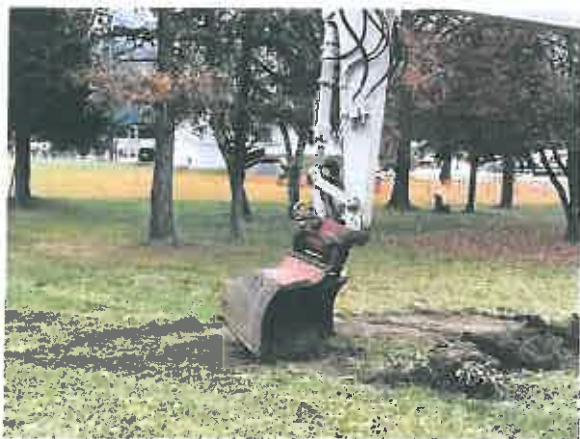
A talaj felső rétegének eltávolítása
